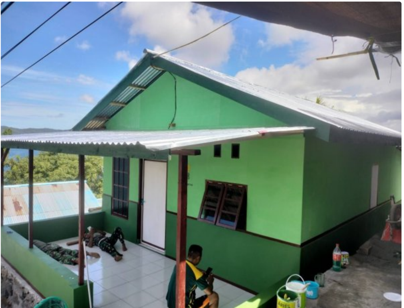
Renovasi RTLH TMMMD Ke-116 Kodim 1310 Bitung
