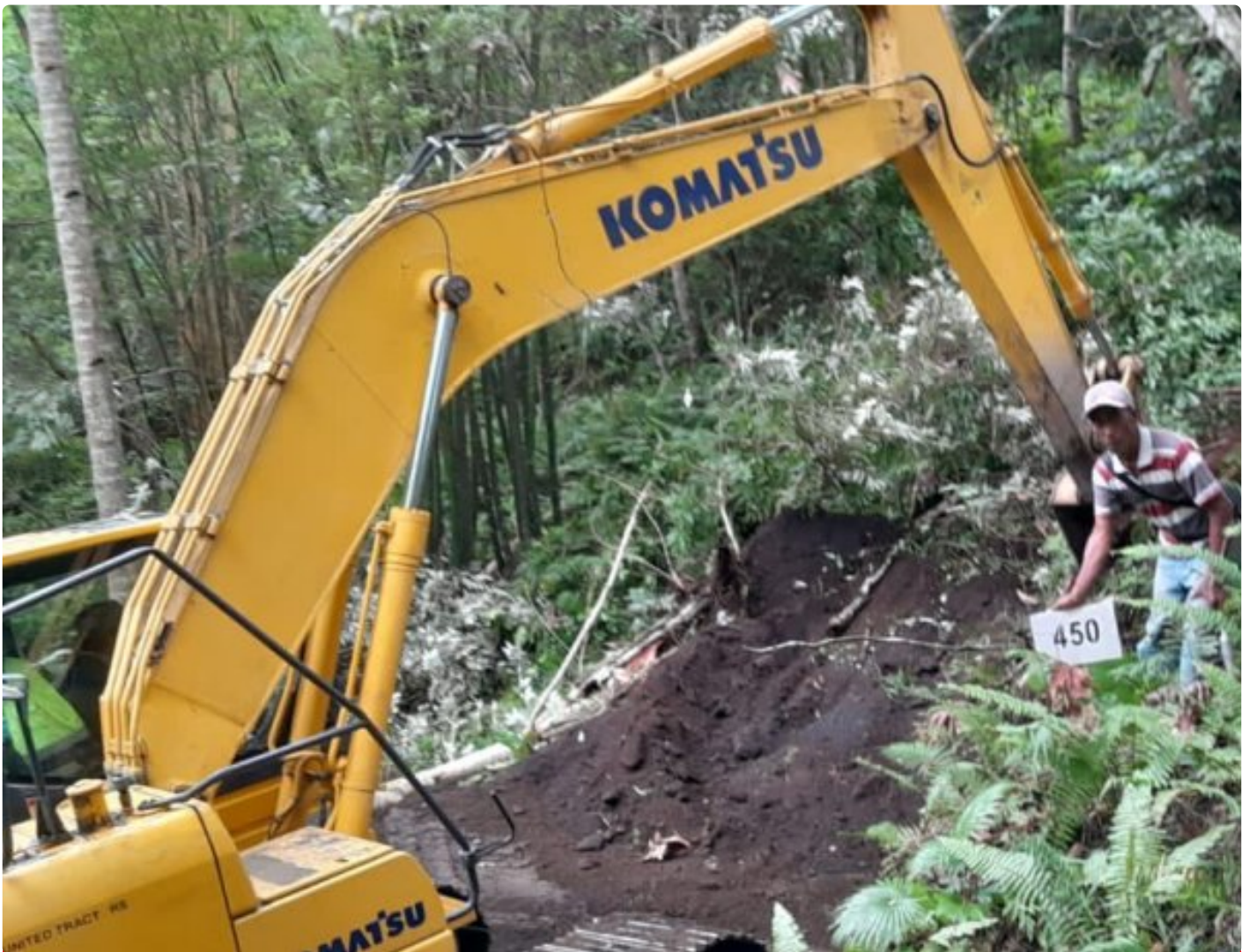
TMMMD Ke-116, Kebut Kerja pembuksan akses Jalan
