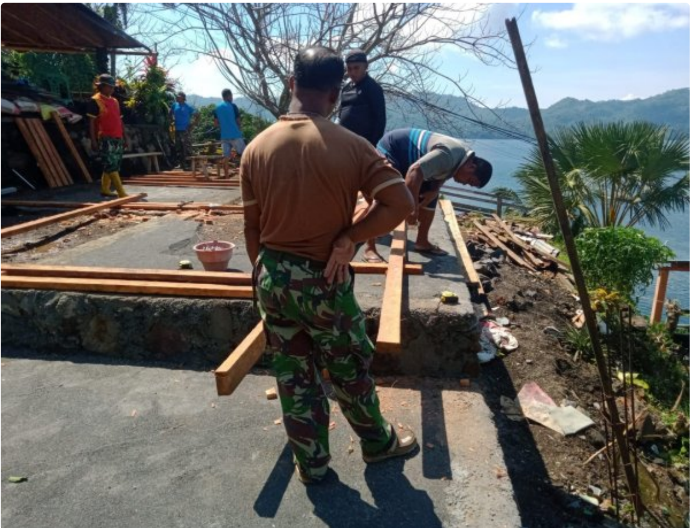
Satgas TMMMD Ke 16, pada Pekerjaan RTLH Warga Kelurahan Tandurusa
