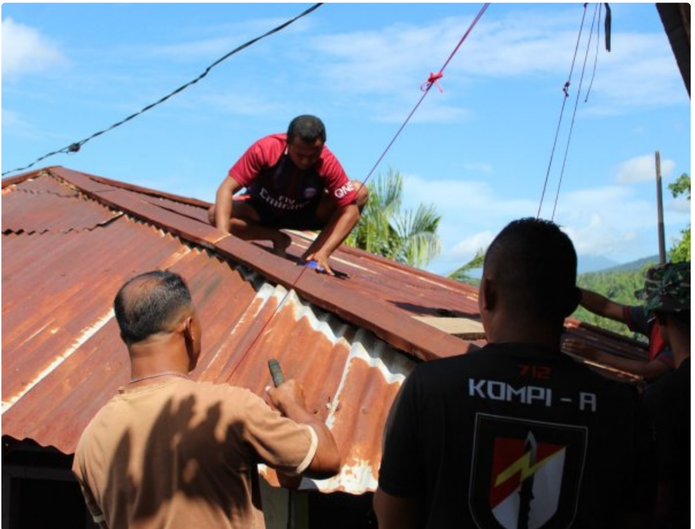
Pembongkaran Bangunan Rumah lama, Keluarga Gavin Karaki Pemema Bantuan. RTLH TMMD Ke 116 Kodim1310 Bitung
