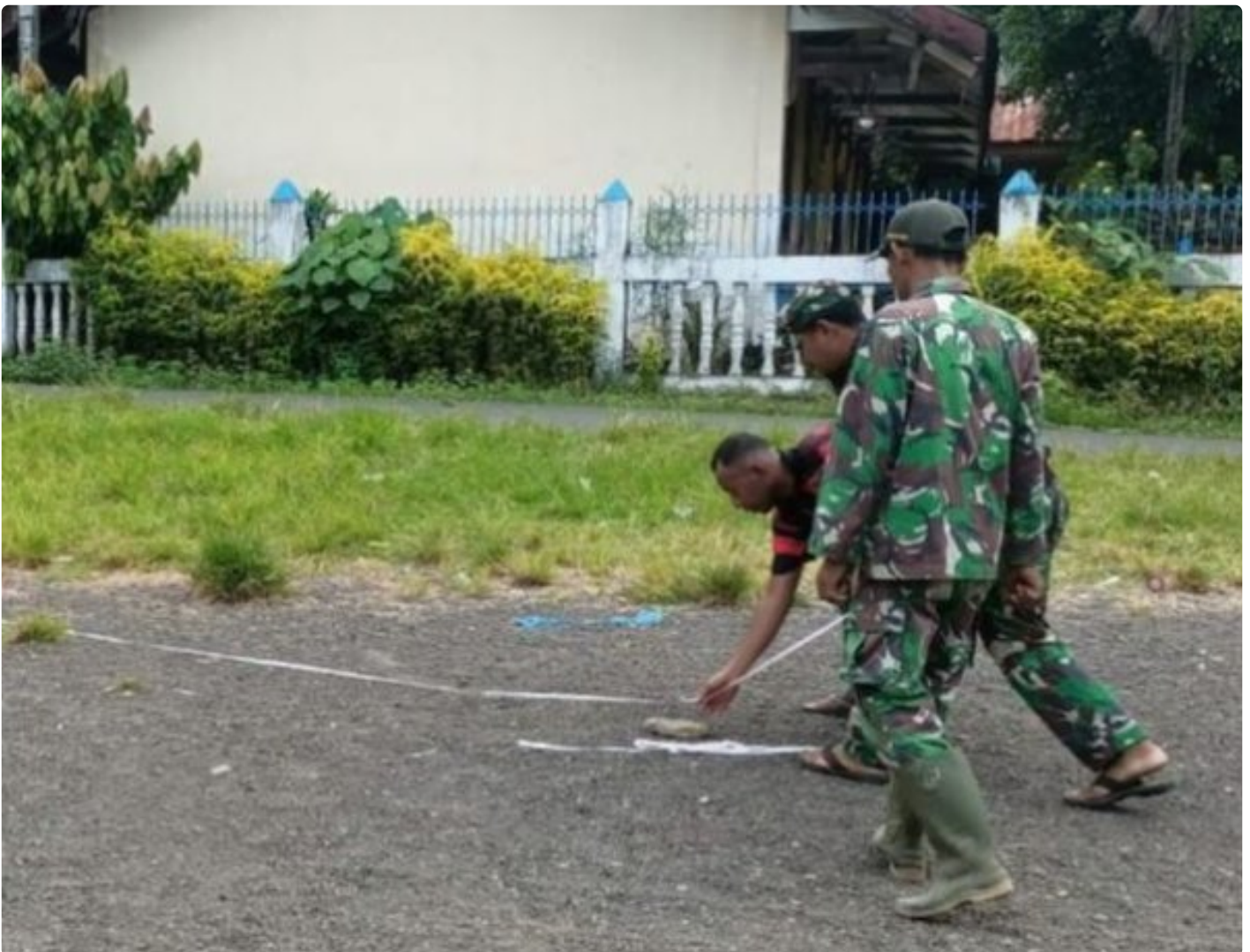
Satgas TMMD Lakukan Pengukuran Pembangunan Sarana Olahraga Jogging Track
