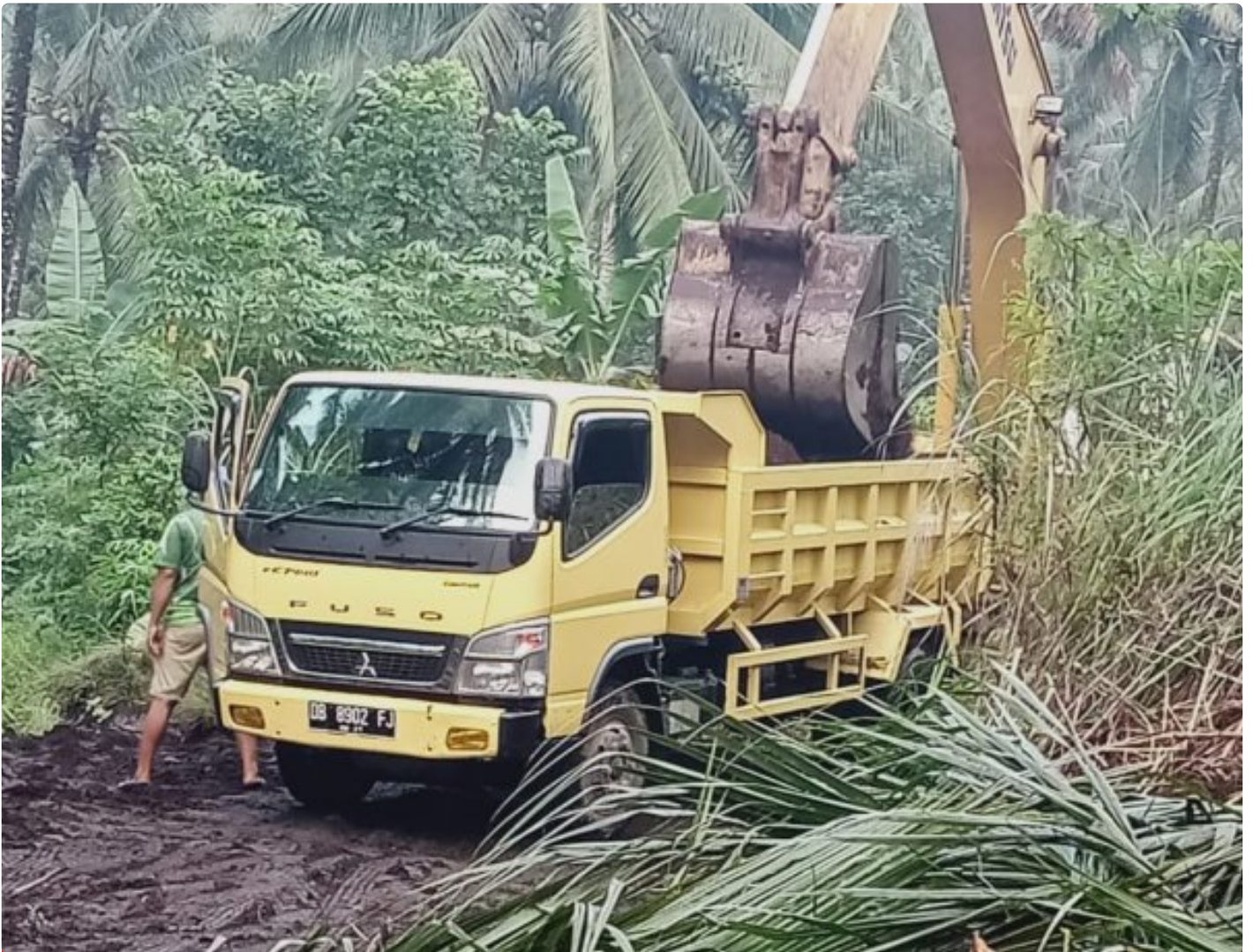
Dump Truk angkut Material Tanah Timbunan Pembangunan Sarana Jogging Track pada TMMD Ke 116 di Kelurahan Tandurusa
